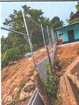
Foto 3: Sustrucción malla de acero galvanizado en perímetro del establecimiento, con instalación fija y tensa, anclajes metalicos en intervalos regulares
