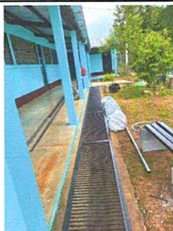
Foto 5: Reparación de cuneta, rejilla metálica.
