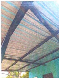
Foto 1: Sustrucción de cubierta de techo con lámina galvanizada, Tipo de lamina: troquelada Calibre: 26, incluye: fijaciones y sellado en traslapes.
