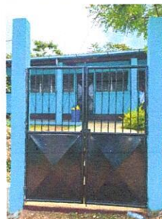
Foto 6: Sustrucción a portón de ingreso, material: metálico, incluye: bisagras y sistemas de cierre.
