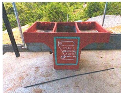
Foto 4: Sustrucción pila, nivelada y con conexiones hidraulicas.
